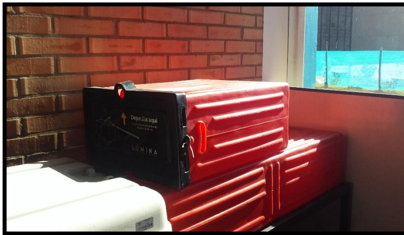
Contenedores de las luminarias en la SADE.
