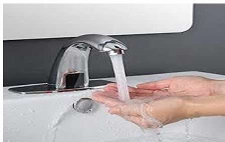
Figura 9. Grifo tipo puff para el ahorro de agua. Fuente: fotografía propia
